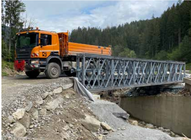
Behelfsbrücke auf der L46
