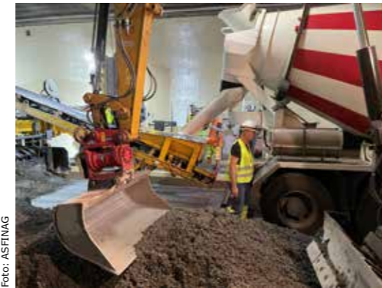
Knapp die Hälfte der alten Fahrbahn wird vor Ort wiederverwendet und eingebaut, nachdem das Material in einer Mischanlage aufbereitet wurde.
