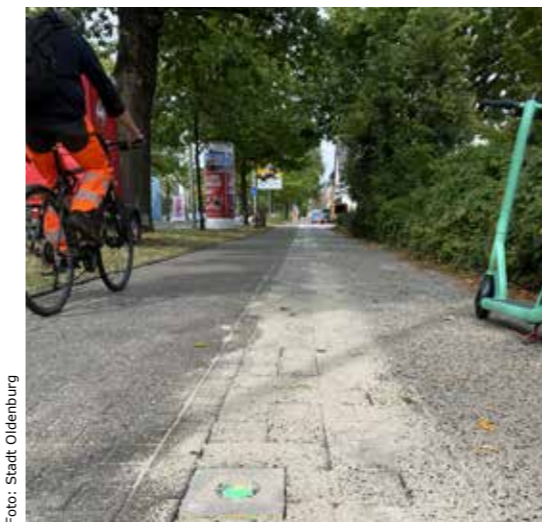
Fußgänger- und Radfahrerfurt mit detektorbasierter Freigabeverlängerung in Oldenburg
