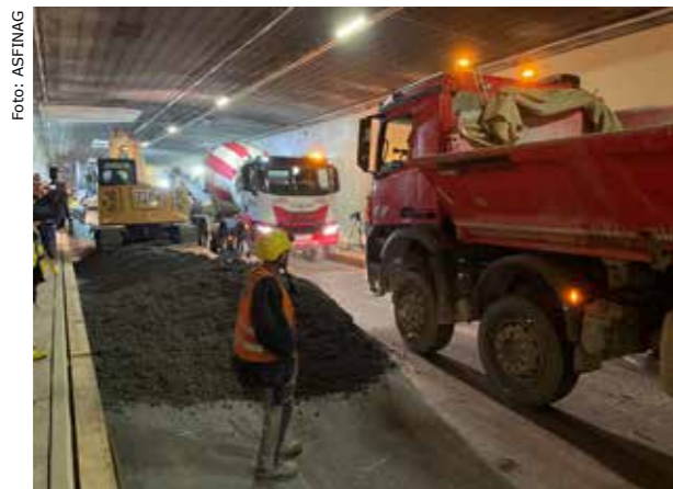
Pro Tag schaffen die Arbeitenden rund 400 Meter Betonfahrbahn und etwa 2.000 Laufmeter an Tunnelbeschichtung.
